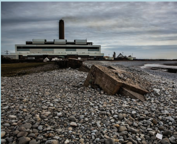
KOHLEKRAFTWERK ABERTHAW, WALES, GB. © cliff hellis
